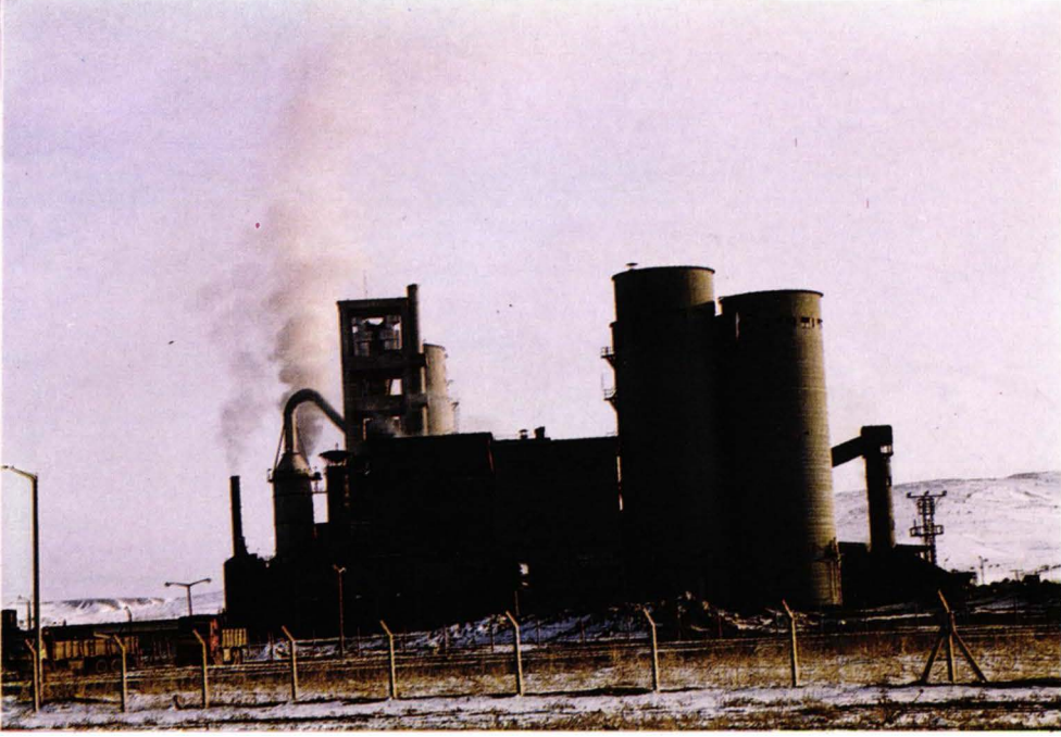
Şanlıurfa çimento fabrikasından bir görünüm
