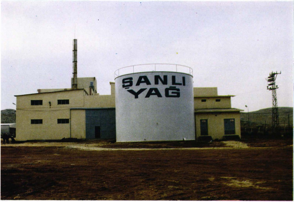
Akçakale yolu üzerinde kurulu Şanlı yağ fabrikası
