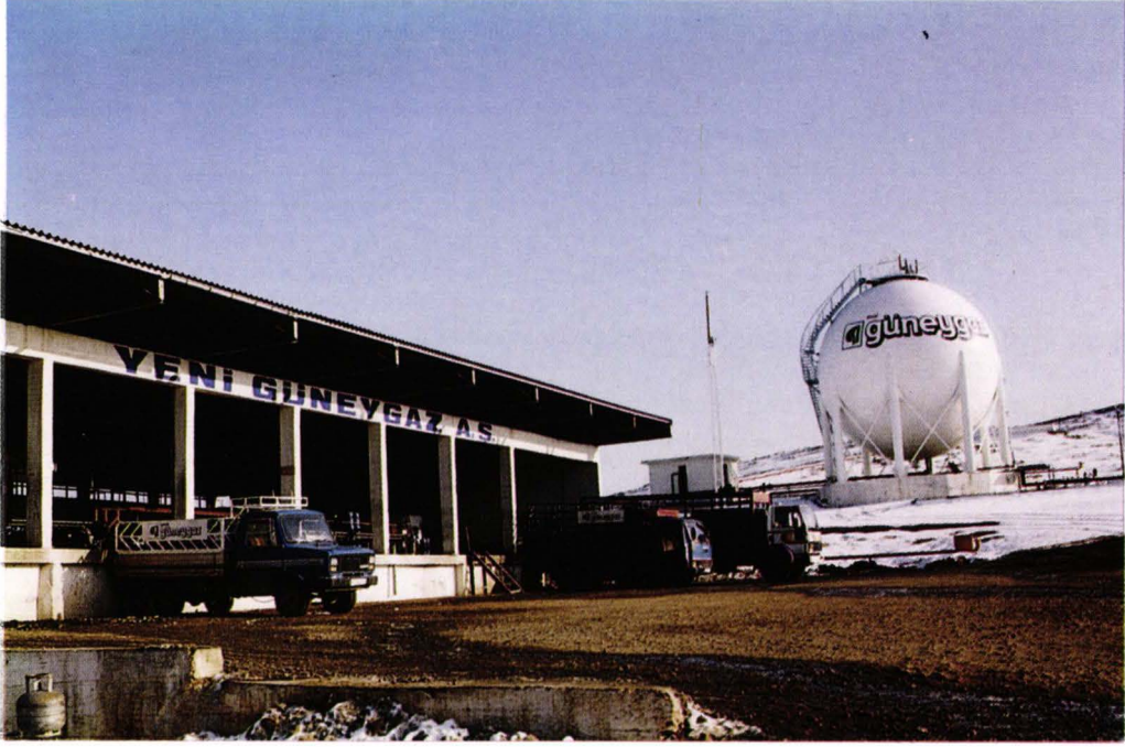
Akabe mevkiinde kurulu Güneygaz tüp dolum tesisi
