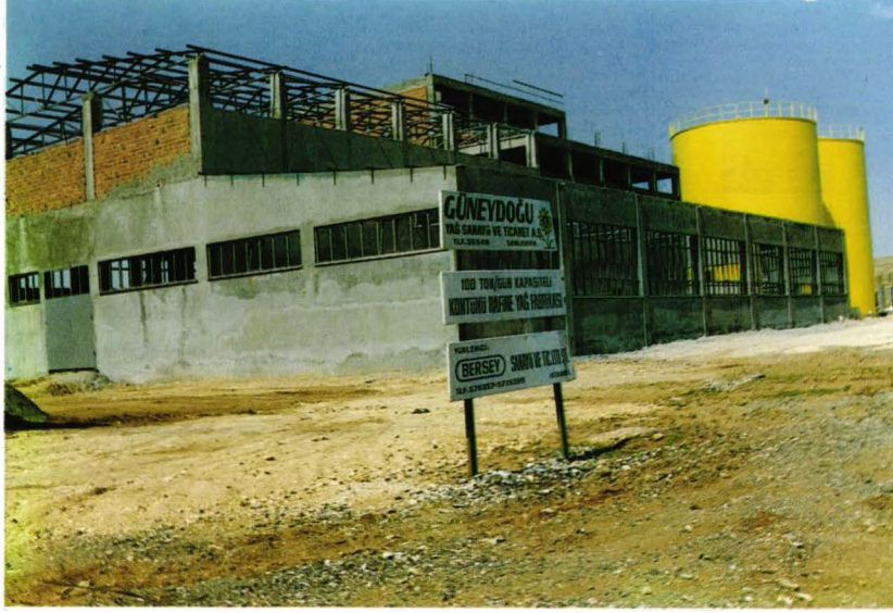
Şanlıurfa Organize Sanayi Bölgesinde yapımı devam eden Güneydoğu Yağ fabrikasından bir görünüm
