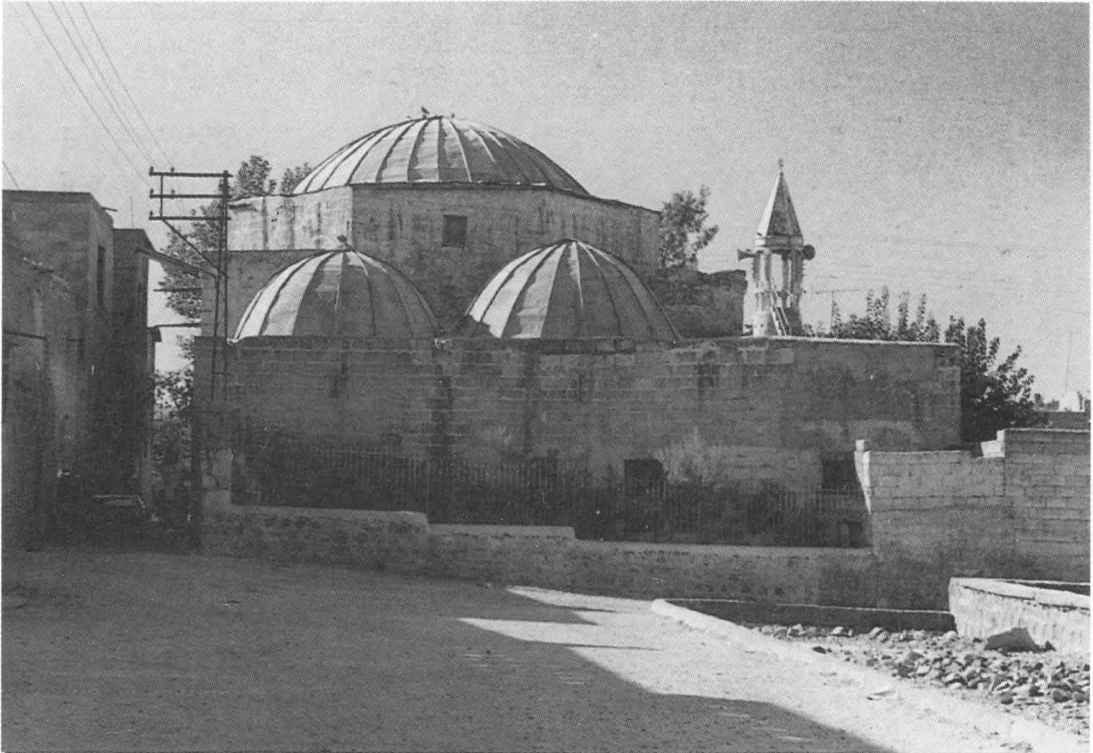
Resim : 25 Çakeri Camii Doğu Cepheden Görünüm
