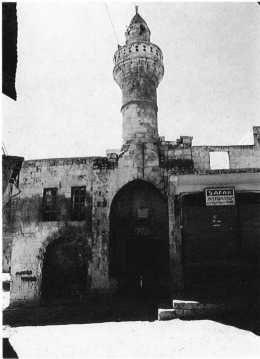
Resim 28 : Kadioğlu Camii Kuzey Cephesi
