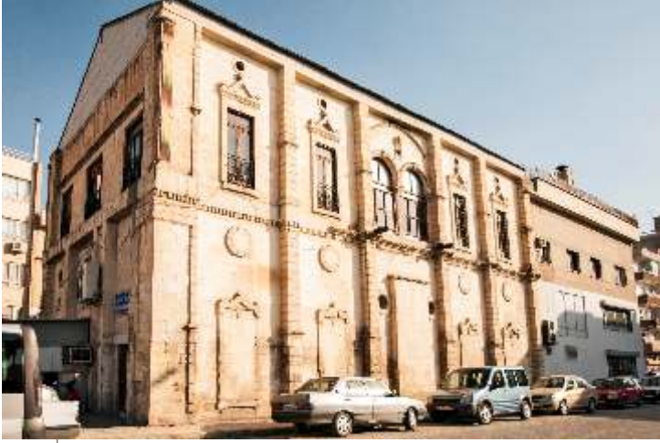
284 | Eski Belediye Binası
