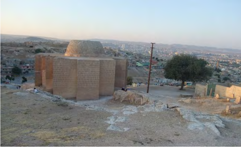
Şeyh Mesut zaviyesi ve türbesi
