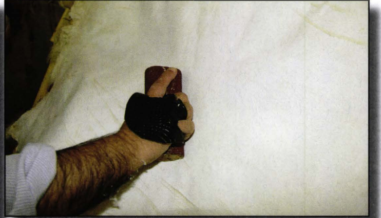
Şekil 204. Yumuşatma, Parlatma ve Zımparalama İşlemi
