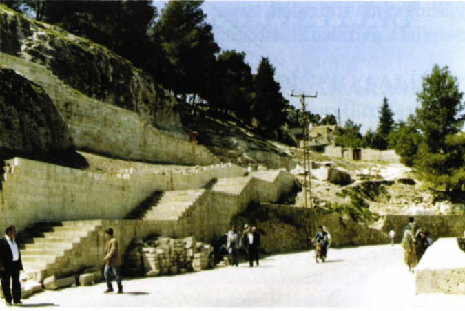
Urfa Kalesi'ne yeni yapılan merdivenler
