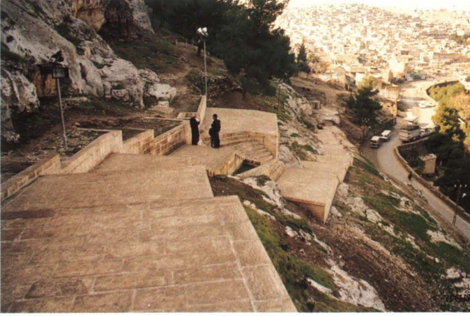
Urfa Kalesi'ne yeni yapılan merdivenler
