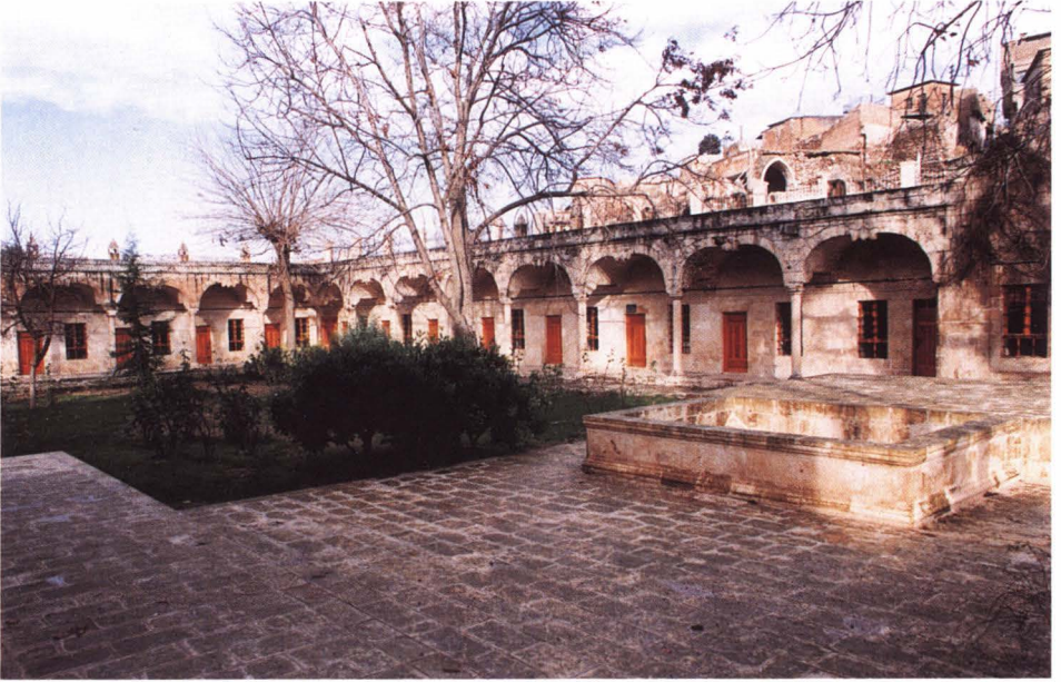
Rızvaniye Medresesi Restorasyon sonrası
