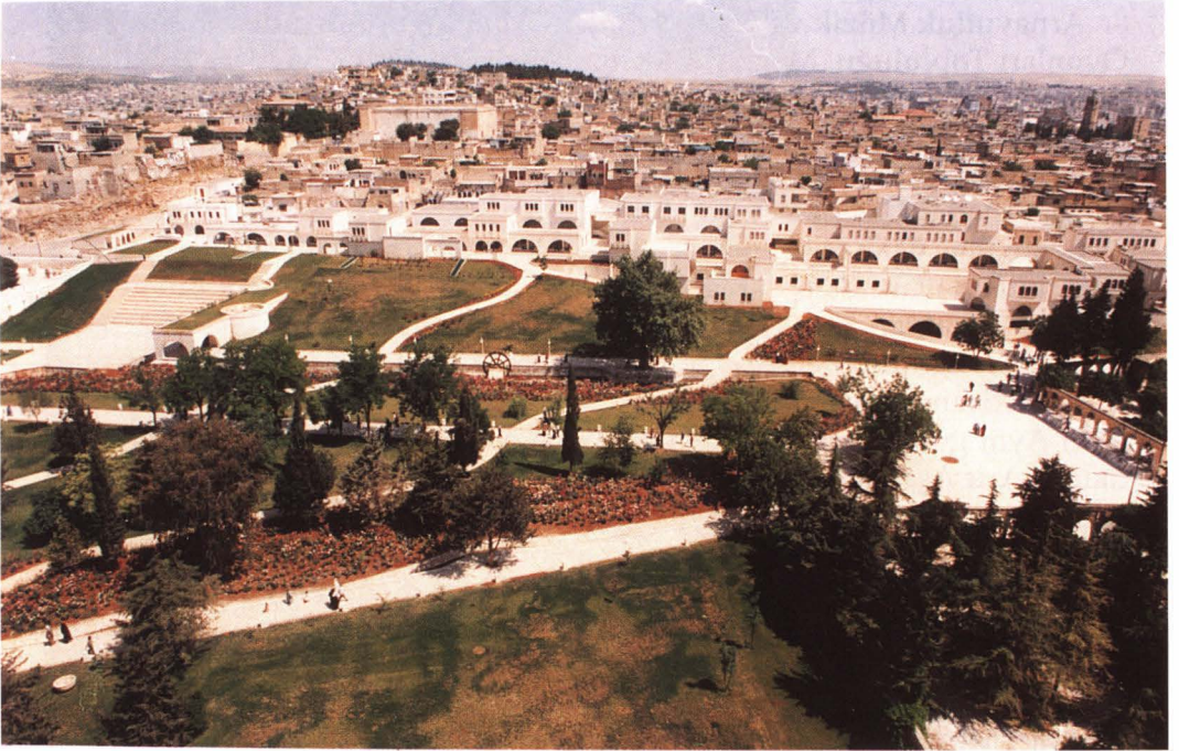
Dergah-Balıklıgöl Çevre Düzenleme Projesi'nin görünümü (Mayıs 1997)
