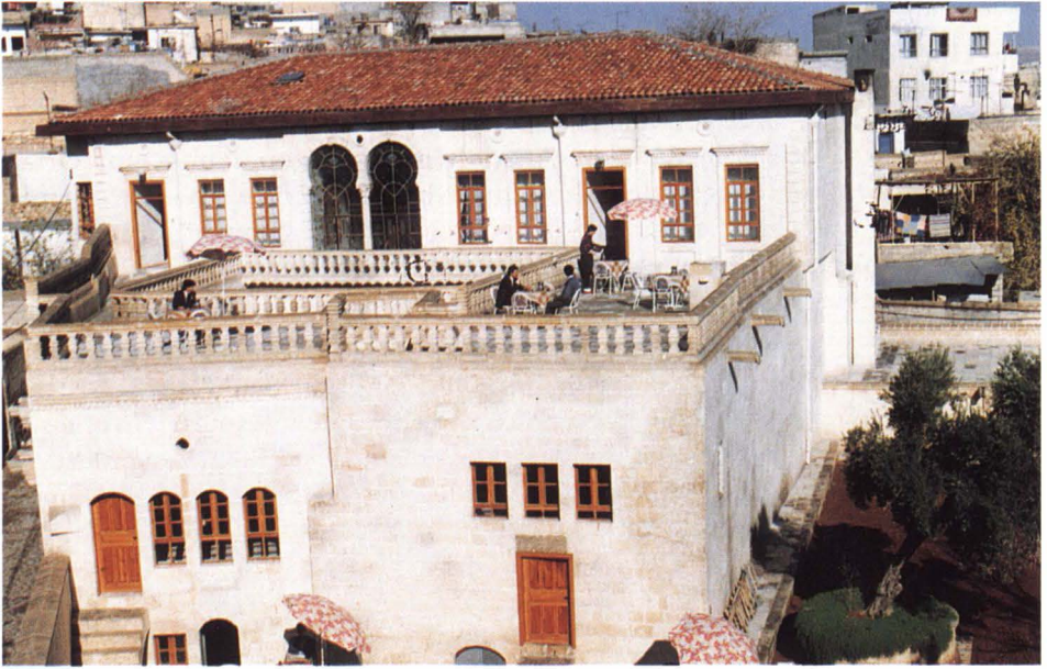
Küçük Hacı Mustafa Hacıkamiloğlu Konağı (Valilik Konukevi) restorasyon sonrası
