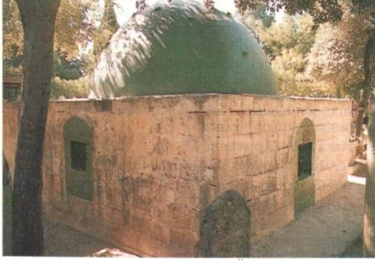
Bediüzzaman türbesi. (Ö.1210)
