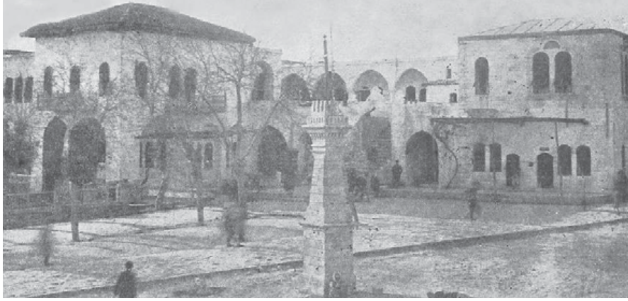
Eski Saray - Eski Hükümet Binası
