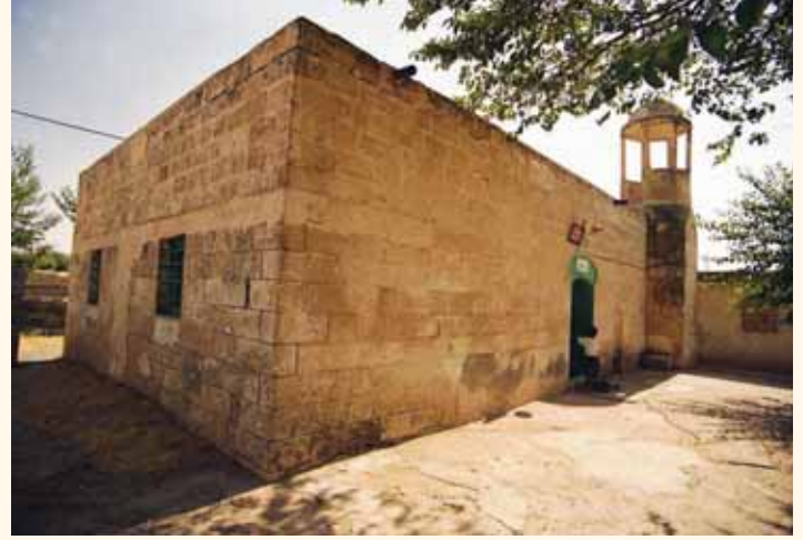
Fotograf 334. Çengelli (Alizera) Köyü Camii kuzey doğudan görünüm.
