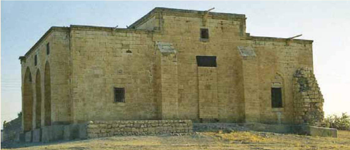
Fotograf 251. Ağvıran Köyü Hüseyin Paşa Camii güney cephesi.
