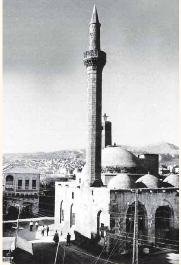
Fotograf 104. Hüseyin Paşa Camii kuzey doğu cepheden görünüm.
