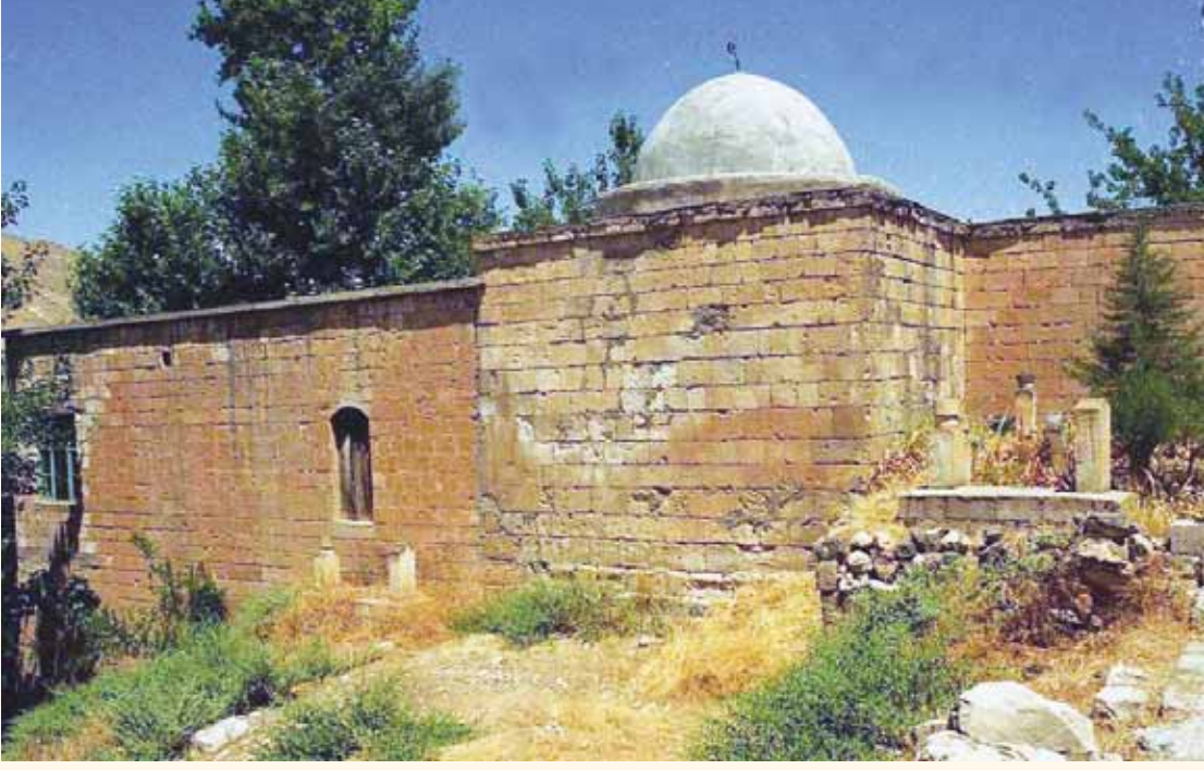
Fotograf 256. Çekem Mahallesi Camii ve Şeyh Hacı Ali Türbesi'nin güney cepheden görünümü.
