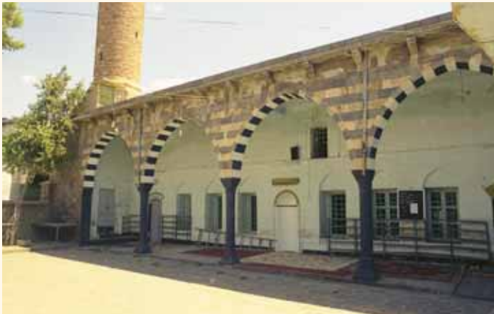
Fotograf 330. Hasan Çelebi Camii son cemaat yeri cephesi.
