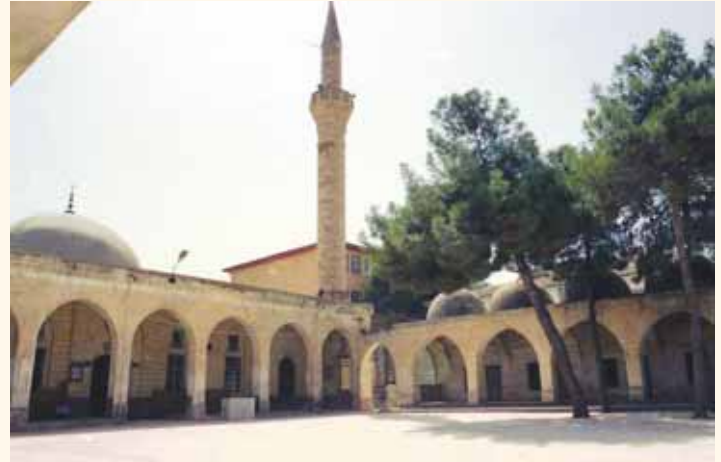
Fotograf 342. Suruç Ulu Camii avlusundan son cemaat yeri cephesi ve avlunun batısındaki medrese odaları.
