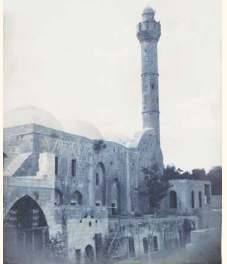
Fotograf 84. Yusuf Paşa Camii doğu cephesi. (İ.Ü. Merkez Kütüphanesi, Sultan II. Abdülhamid Yıldız Fotograf Albümleri'nden).
