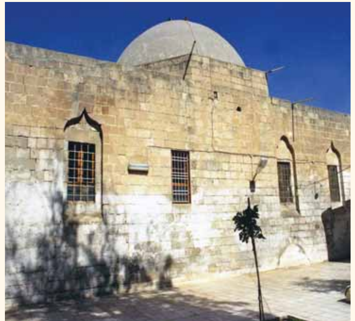
Fotograf 32. Hacı Lütfullah Camii güney cephesi.
