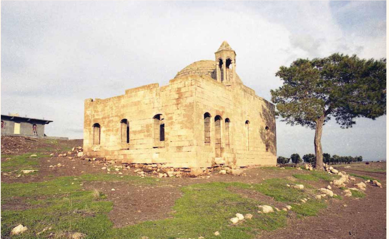
Fotograf 188. Çamurlu Köyü Camii güney batıdan görünüm.
