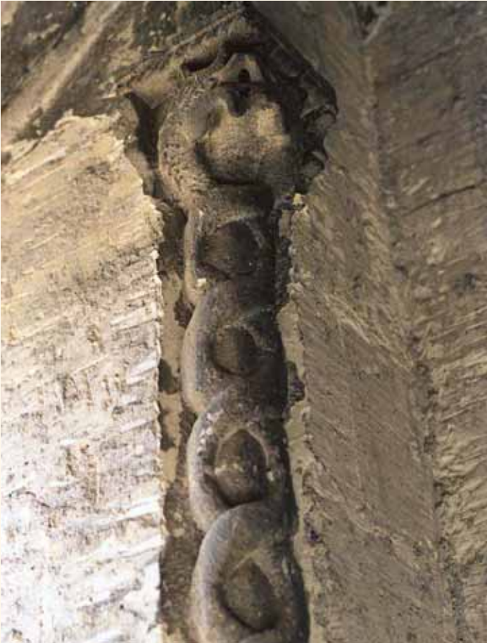
Fotograf 184. Selahattin Eyyubi Camii pencere pahlarında zincirleme dolanmış çift ejder kabartması.
