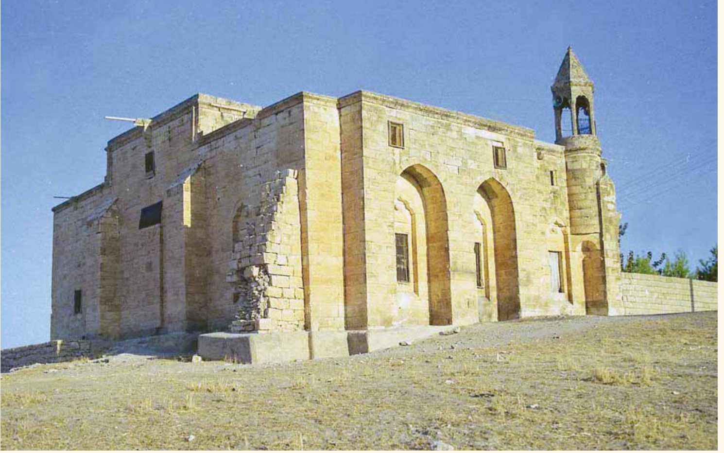
Fotograf 252. Ağvıran Köyü Hüseyin Paşa Camii güney doğu cepheden görünüm.
