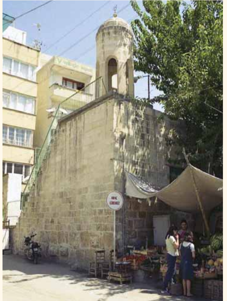
Fotograf 236. Tekke Camii'nin güney batı cepheden görünümü. (Restorasyondan sonra).
