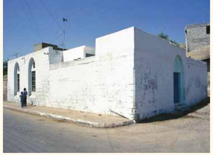
Fotograf 141. Nur Ali Mescidi kuzey doğu cepheden görünüm.
