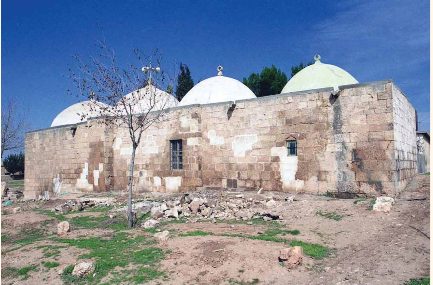
Fotograf 196. Cabir el-Ensar Köyü Camii güney cephesi.
