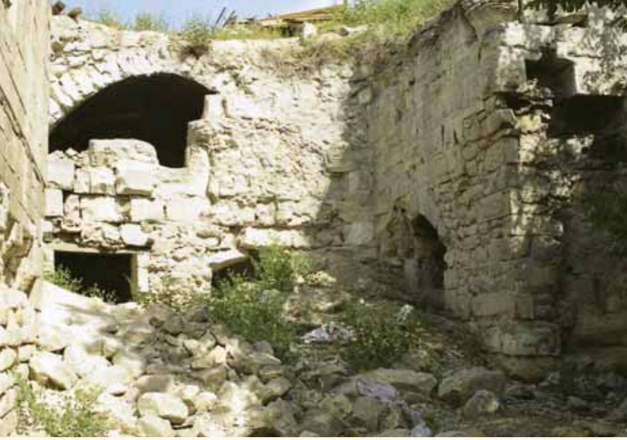
Fotograf 228. Kule Mescidi batı cephesi. (Restorasyondan önce).
