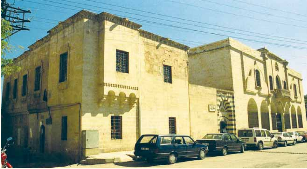
Fotograf 182. Selahattin Eyyubi Camii batı cepheden görünüm.(Restorasyondan sonra).
