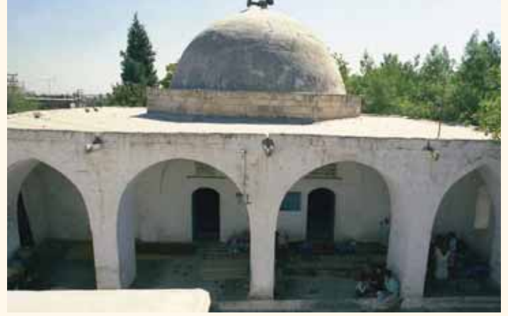
Fotograf 30. Hacı Lütfullah Camii son cemaat yeri cephesi.
