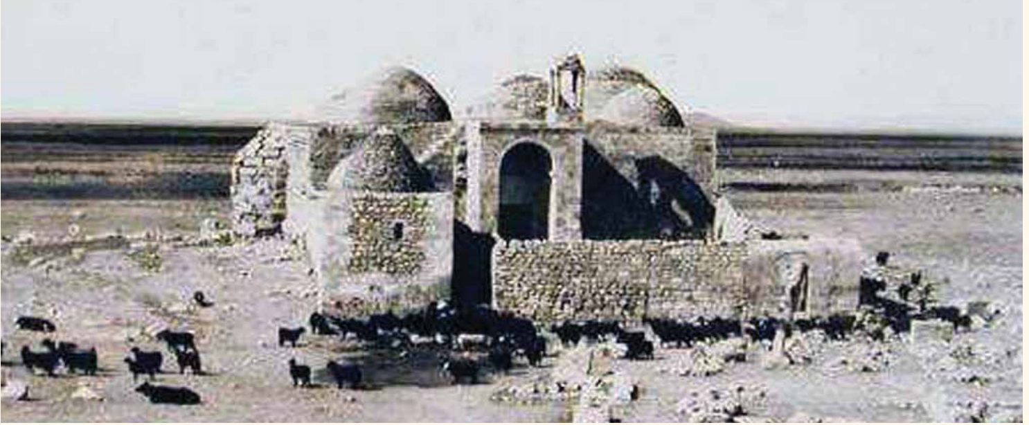
Fotograf 308. Şeyh Yahya Hayat el-Harrani Camii ve Türbesi'nin doğu cepheden görünümü. (K.A.C.Creswell'den).
