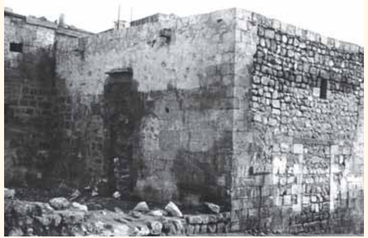
Fotograf 116. Asım Paşa Mescidi kuzey batı cepheden görünüm.
