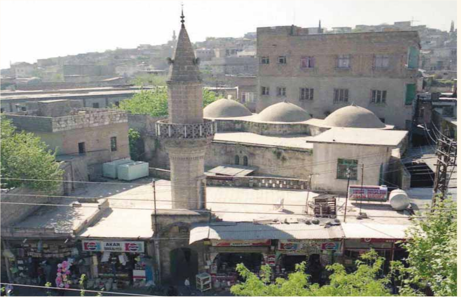
Fotograf 68. Narıncı Camii kuzey cepheden görünüm.
