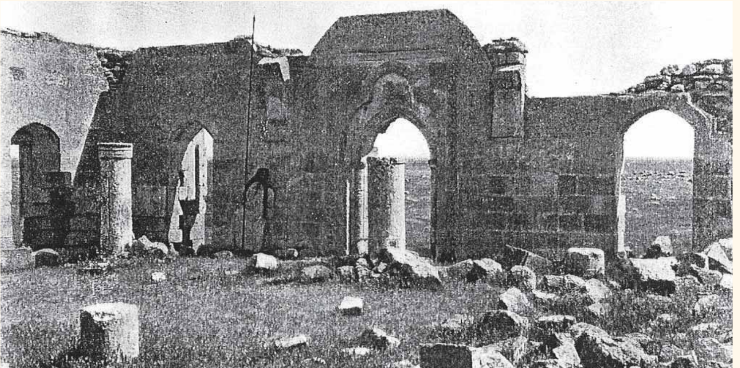
Fotoğraf 316. Harran Küçük Camii mihrap önü bölümü. (Gertrude Bell'den).
