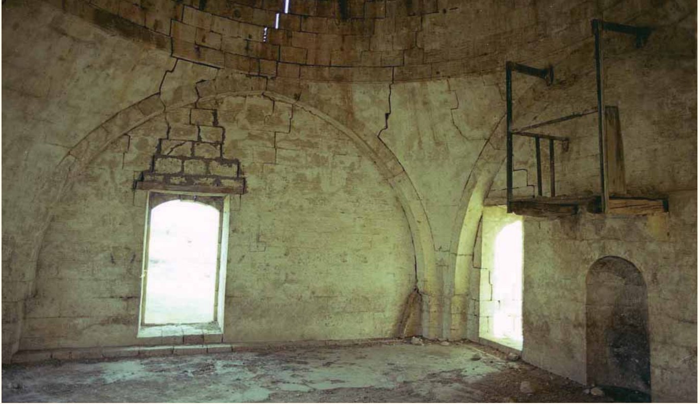
Fotograf 189. Çamurlu Köyü Camii iç görünüm.
