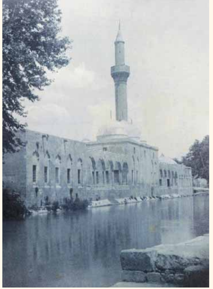
Fotograf 72. Rıdvaniye Camii güney cephesi. (İ.Ü. Merkez Kütüphanesi, Sultan II. Abdülhamid Yıldız Fotograf Albümleri'nden).
