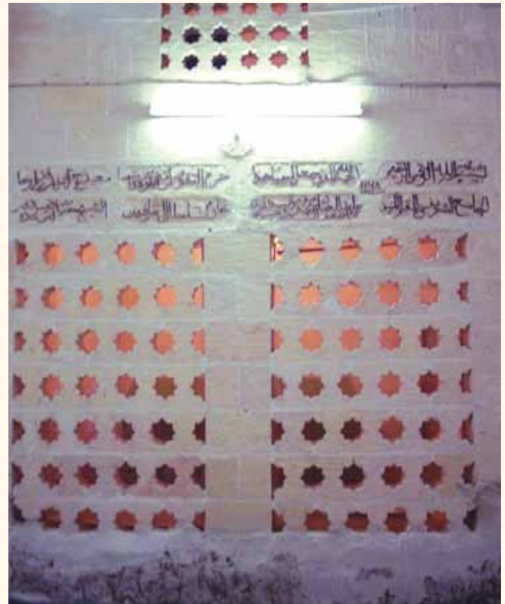
Fotograf 312. Şeyh Yahya Hayat el-Harrani Camii ve Türbesi'ni ayıran duvarın cami içerisinden görünümü.
